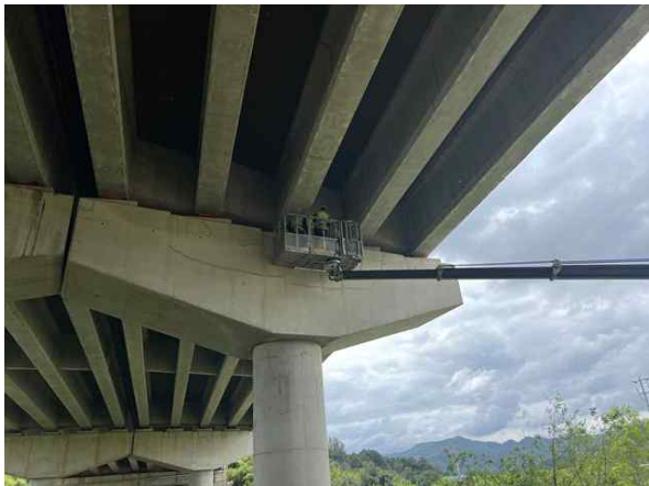
고소점검차를 이용한 근접조사
