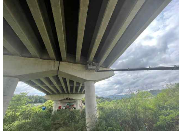
고소점검차를 이용한 근접조사
